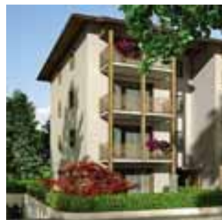
Il progetto della Residenza verdiana in costruzione a Clusone
